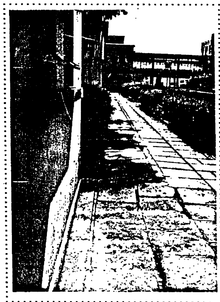
FOTO No. 5 : BLOQUE 'A'. Asentamiento del terreno en caminerías.
