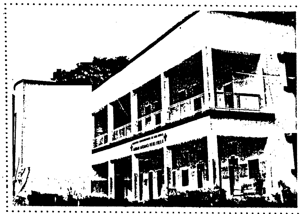
FOTO No. 2 : BLOQUE 'A'. Fachada Acceso Principal.
