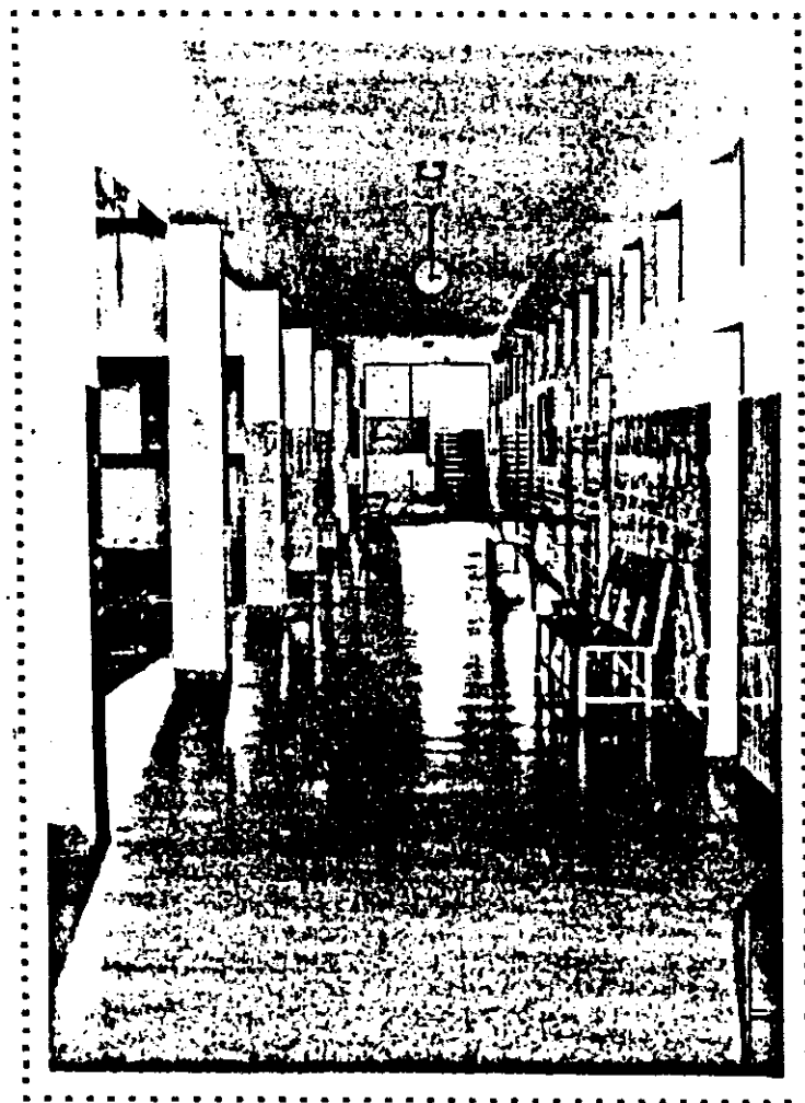
FOTO NO. 6 : BLOQUE 'A'. Pasillo central y Nucleo de Escaleras 1.
