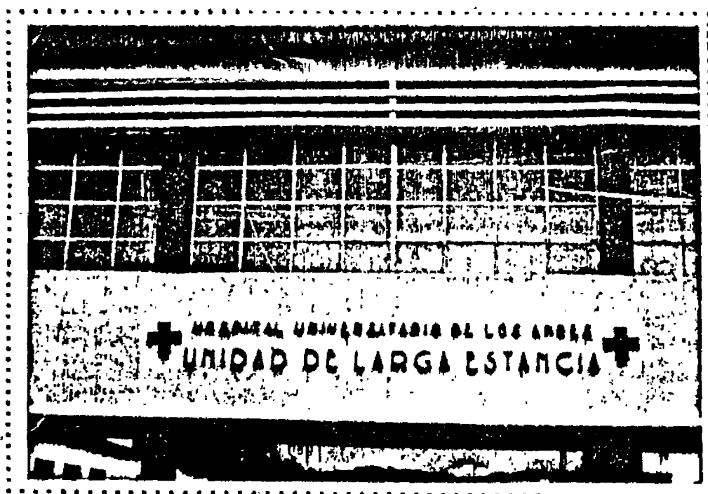
FOTO No. 36 : Vista Nivel 2 Pasarela de Comunicación B-C.
