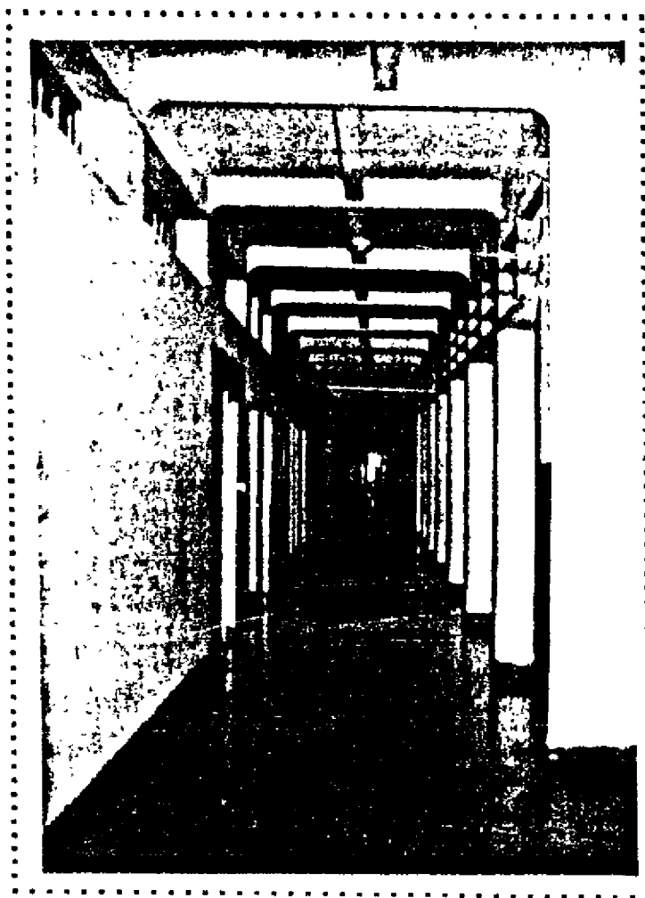
FOTO No. 52 : BLOQUE 'C'. Pasillos Internos
