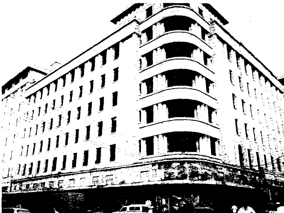
El Edificio Comercial, ubicado en el corazón de la capital, se mantiene en pie luego de siete años del
