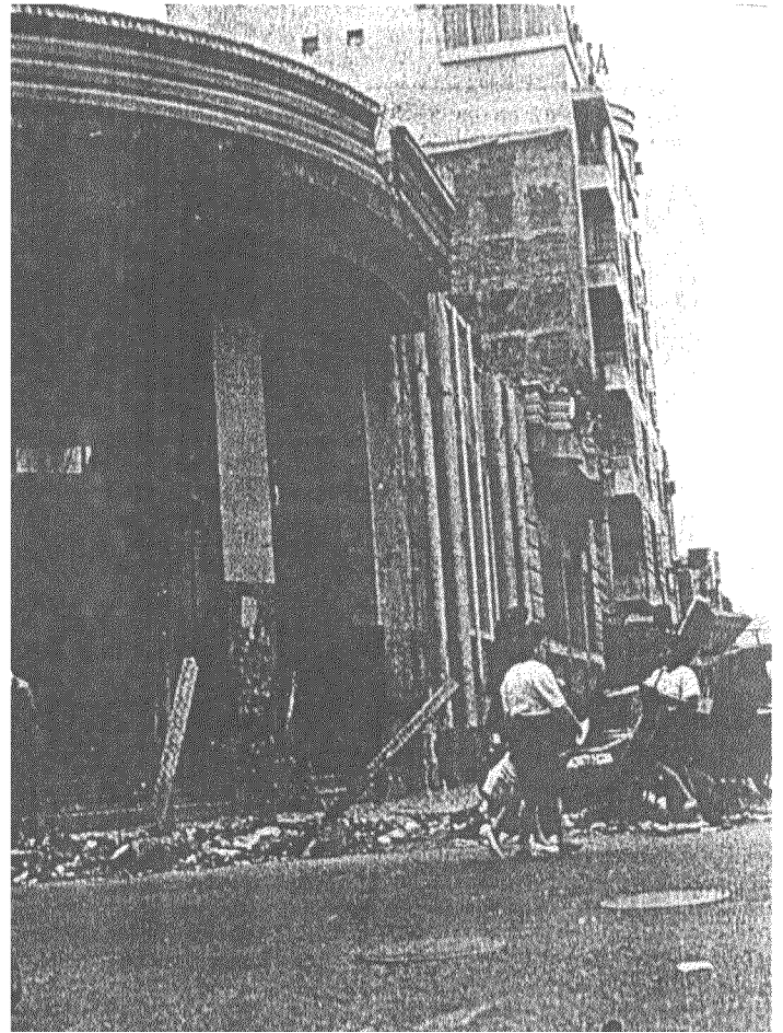
ESCOMBROS. Todavía quedan tristes recuerdos del terremoto que estremeció la capital el 10 de octubre de 1986, cuando el reloj marcaba las 11.50; el edificio donde estaba el Banco de Crédito Popular todavía no ha sido demolido en su totalidad.
