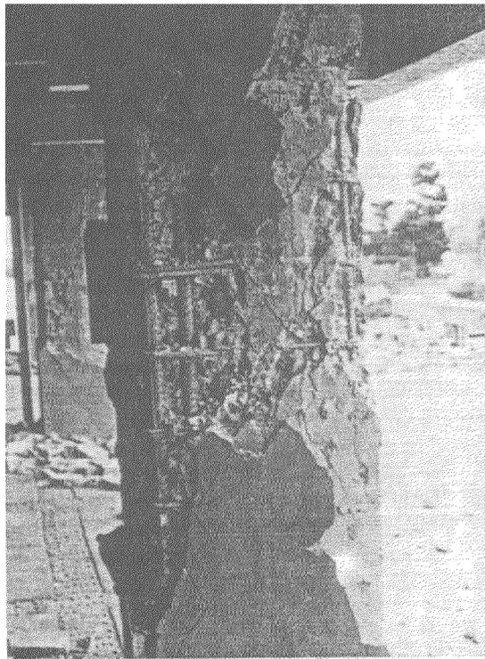
Fig. 5(b)—Daño en pilares de hormigón armado
