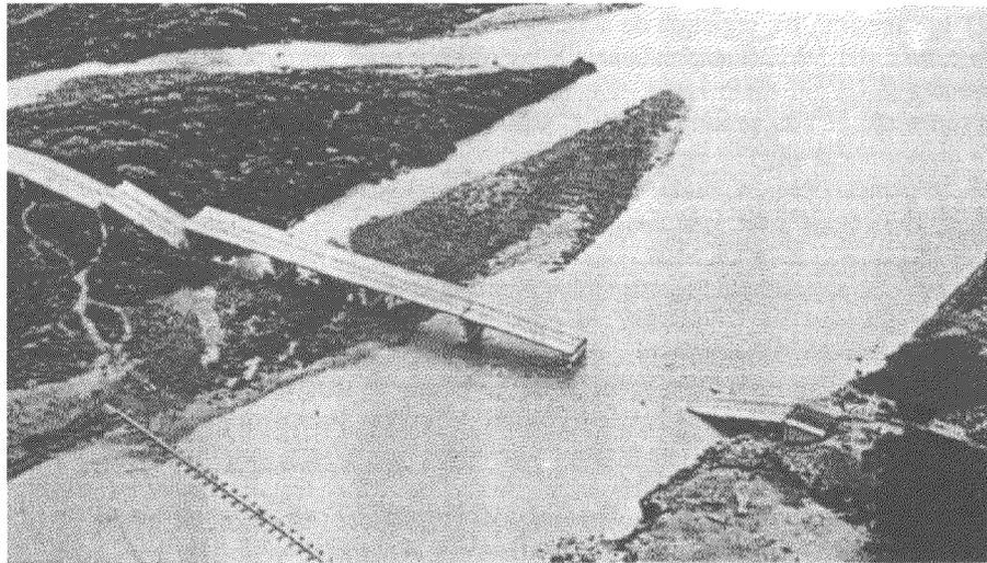
Fig. 17.—HUNDIMIENTO DEL PUENTE DE LO GALLARDO DURANTE EL TERREMOTO DE CHILE DE 1985.
