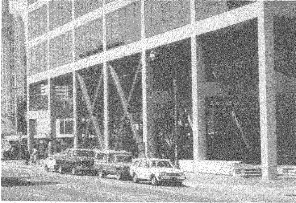
(1) Vista general del edificio: Se usaron arriostramientos metálicos para rigidizar lateralmente el edificio original de hormigón armado.
