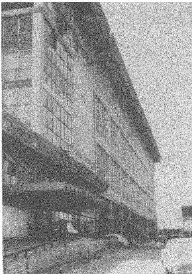
Fig. 48(a) Vista general del edificio: la marquesina de hormigón en la parte posterior del edificio ha sido retirada.
