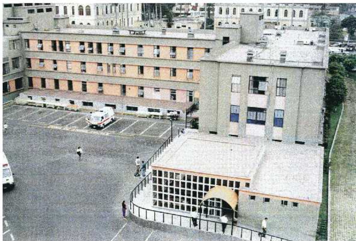
FOTO No. 2: HOSPITAL NACIONAL "GUILLERMO ALMENARA IRIGOYEN", EDIFICACION EN DONDE SE UBICA EL GRUPO ELECTROGENO.
