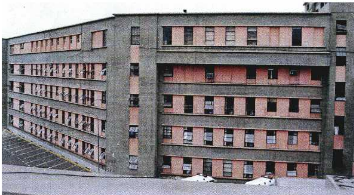
FOTO No. 9: HOSPITAL NACIONAL "GUILLERMO ALMENARA IRIGOYEN", EDIFICIO CENTRAL DEL PABELLON "A", VISTA PARCIAL DEL PABELLON 'A'. SE OBSERVA EL EDIFICIO ALA ESTE (IZQUIERDA) Y LA MITAD DEL EDIFICIO CENTRAL (DERECHA).
