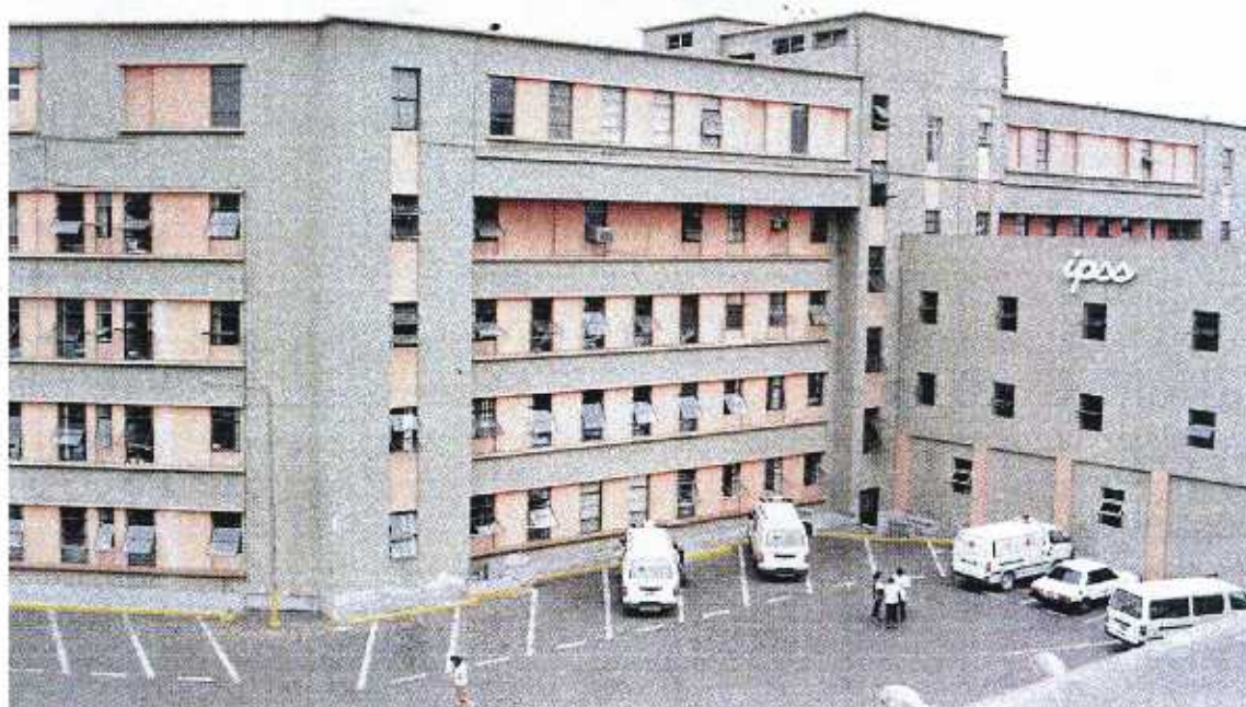
FOTO No. 10: HOSPITAL NACIONAL "GUILLERMO ALMENARA IRIGOYEN", EDIFICIO CENTRAL DEL PABELLON "A", FOTO TOMADA DESDE LA AZOTEA DEL EDIFICIO ALA ESTE DEL PABELLON PRINCIPAL, A LA IZQUIERDA SE PUEDE NOTAR LA JUNTA QUE DIVIDE A LOS EDIFICIOS CENTRAL Y ALA ESTE.
