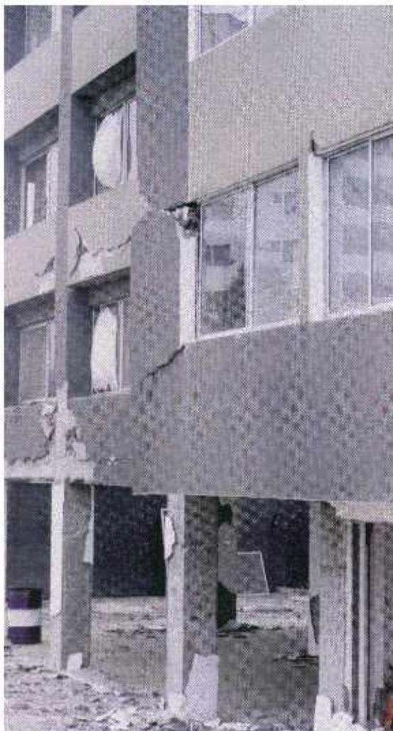
a) Los daños en tabiquerías y paredes interiores, y en algunas exteriores, así como la frecuente fisuración de losas y vigas, reflejan una excesiva flexibilidad de buena parte de las estructuras soportantes.
