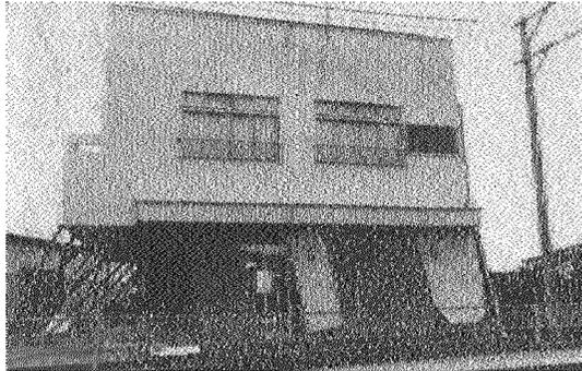
***Fotografía 6*** *Inclinación del primer nivel de edificio (rango C).*
