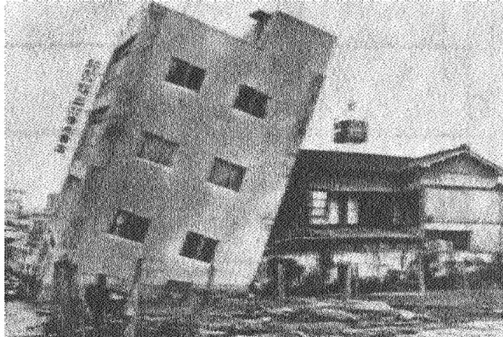
*Figura A.3 Ejemplo de daño de un edificio con desplomo mayor a 2 grados de inclinación total*
