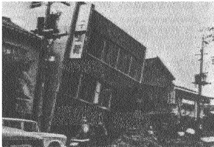
*Figura A.4 Ejemplo de un edificio cuyo asentamiento es superior a 1.0 m*
