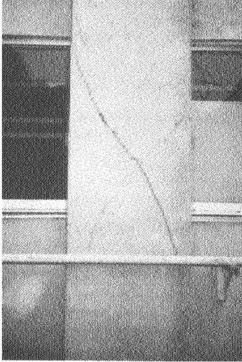
***Fotografía 11. Aspecto del daño de  $1C_{A15}$ ; el nivel de daño es III***
