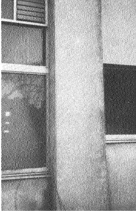
**Fotografía 13. Aspecto del agrietamiento por cortante de  $1C_{A16}$ . El nivel de daño es II. La anchura de agrietamiento del interior es igual a 0.45 mm**
