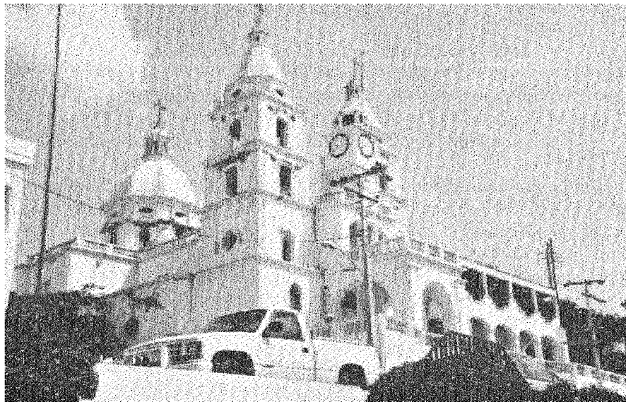
Fotografía 50. Vista general de la parte frontal de la iglesia. Fotografía tomada desde la plazuela central de la ciudad de Cihuatlán.
