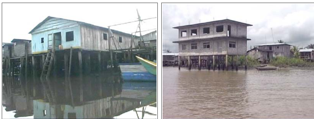
Foto 1. Cambio de materiales flexibles por rígidos.
