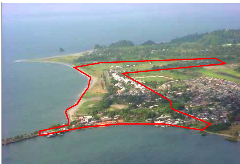
Foto 6. Sectores 18 y 19 alto potencial de licuación, sobre rellenos hidráulicos.
