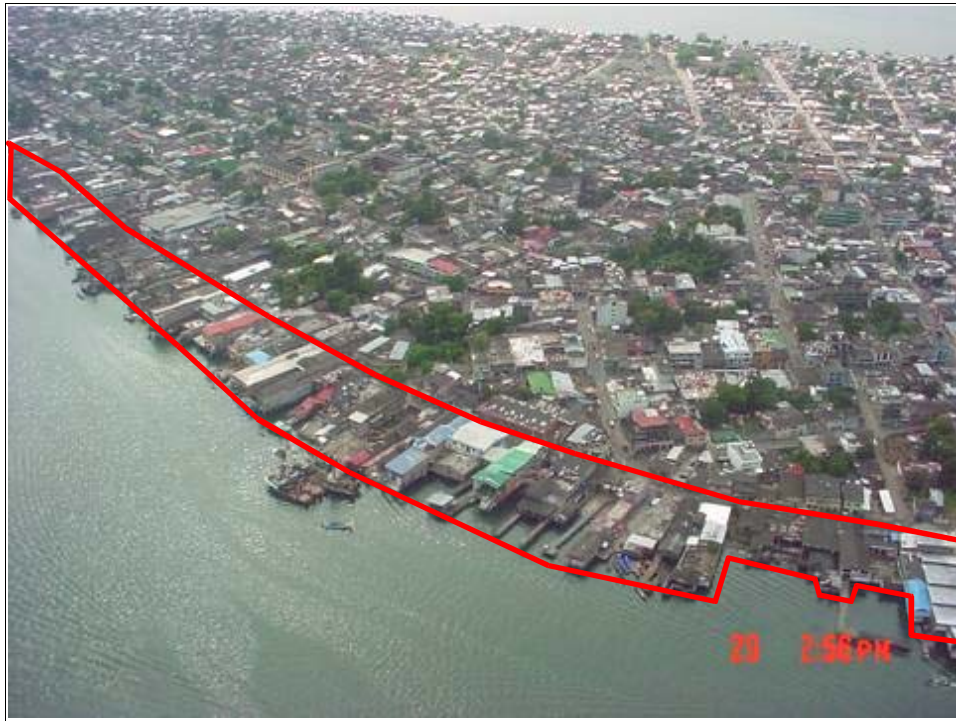
Foto 12. Zona de muelles públicos, Sector 16, sobre terrenos potencialmente licuables.
