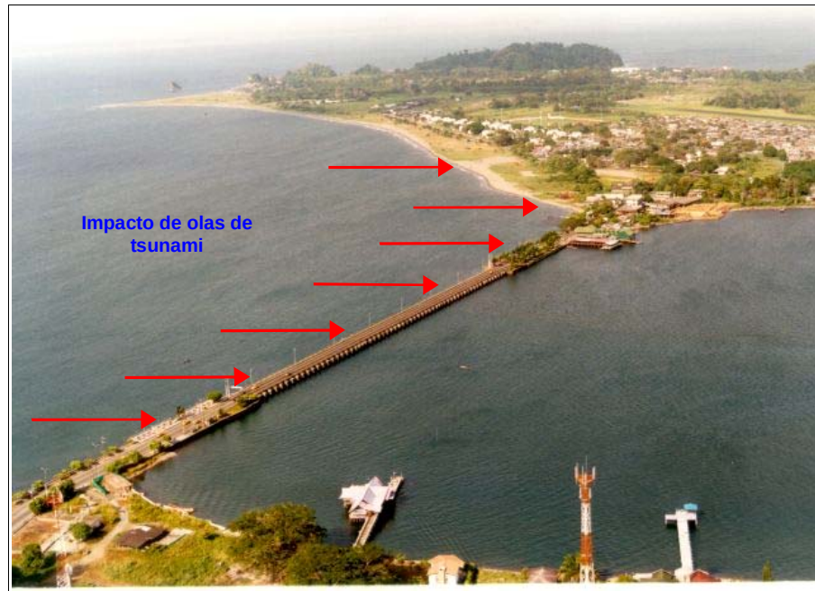
Foto 9. El Viaducto El Morro, altamente expuesto por impacto por Tsunami.
