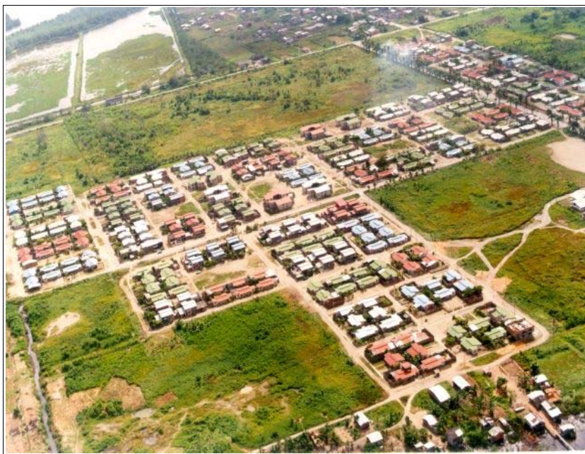
Foto 8. Sector 29, barrio la Ciudadela, sobre un relleno técnicamente construido.
