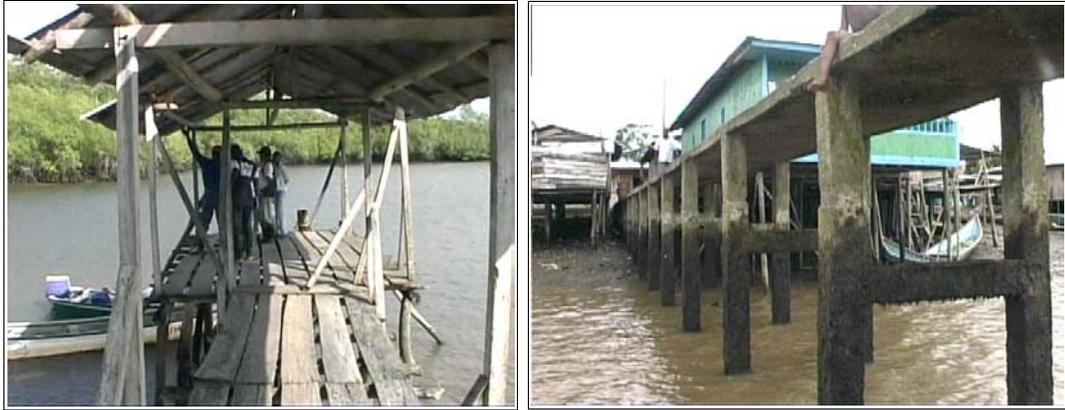
**Foto 32.** Muelles de madera y concreto deteriorados.
