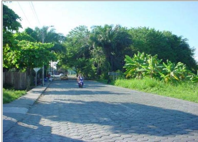
**Foto 20.** Vía adoquinada sobre relleno hidráulico.
