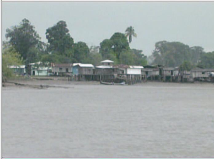
En el encuentro del Estuario Bajadero y el río La Tola, en las coordenadas N 2° 31' 44" y W 78° 16' 01". Hubo hundimientos de los pilotes de todas las edificaciones y agrietamientos en el suelo durante el terremoto de 1979, después del cual empezó a ser inundada en marea alta. Tiene más de 310 habitantes, una escuela donde estudian 100 personas, un muelle de 80 m de longitud y alrededor de 60 viviendas en madera
