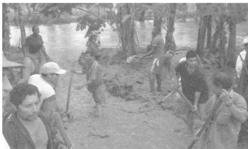
Trabajos de recuperacion en zona bananera.
