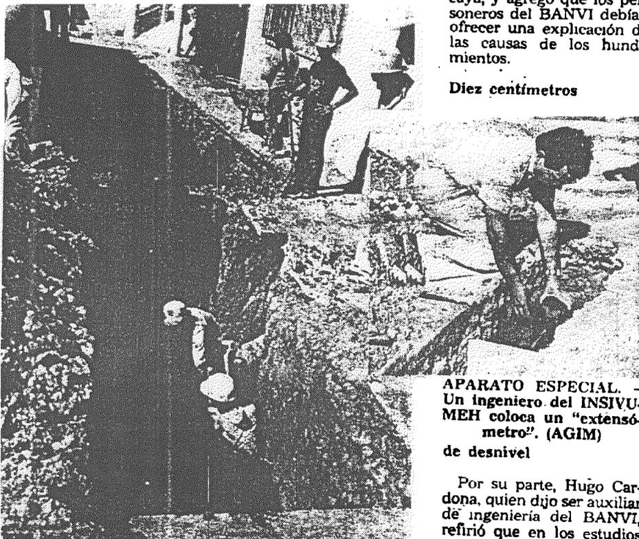
EXCAVAN. Cuadrillas de trabajadores hacen una excavación, para determinar las causas del hundimiento de las casas. (AGIM).
