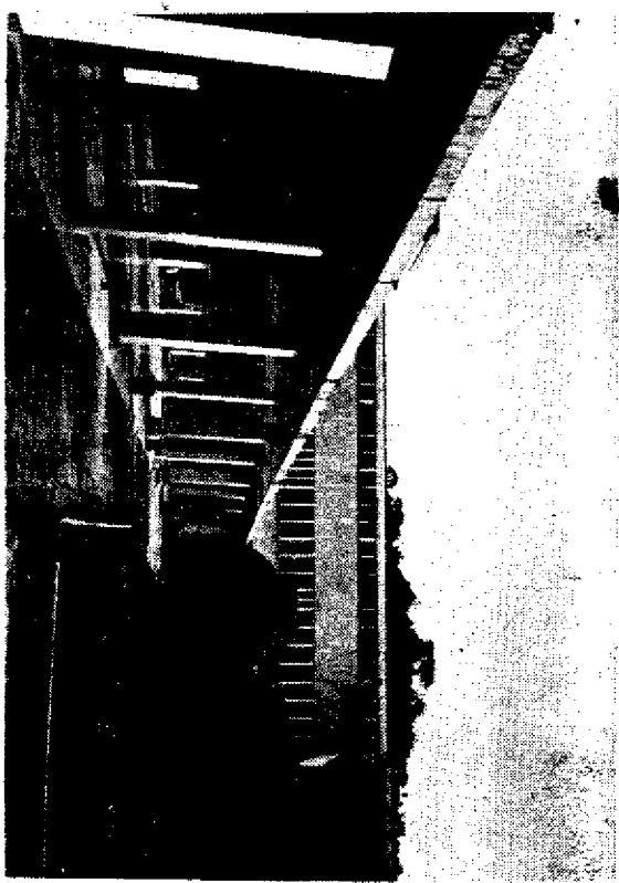
FOTO N° 2: Colegio Salesiano Ricabelli (CSR). Al fondo el bloque de 3 pisos. En el 1er. plano el pasadizo techado. Note los daños y las columnas reforzadas de mayor sección.
