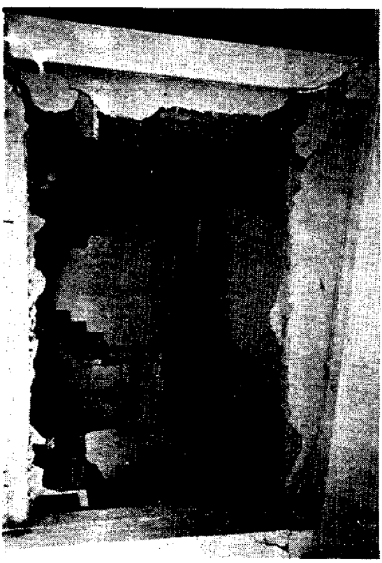
FOTO N° 4: Vista interior de CSR con daños en muros y columnas.
