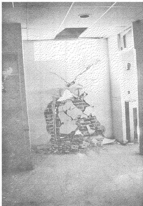
FOTO N° 23: Vista interior de la F. 22.
