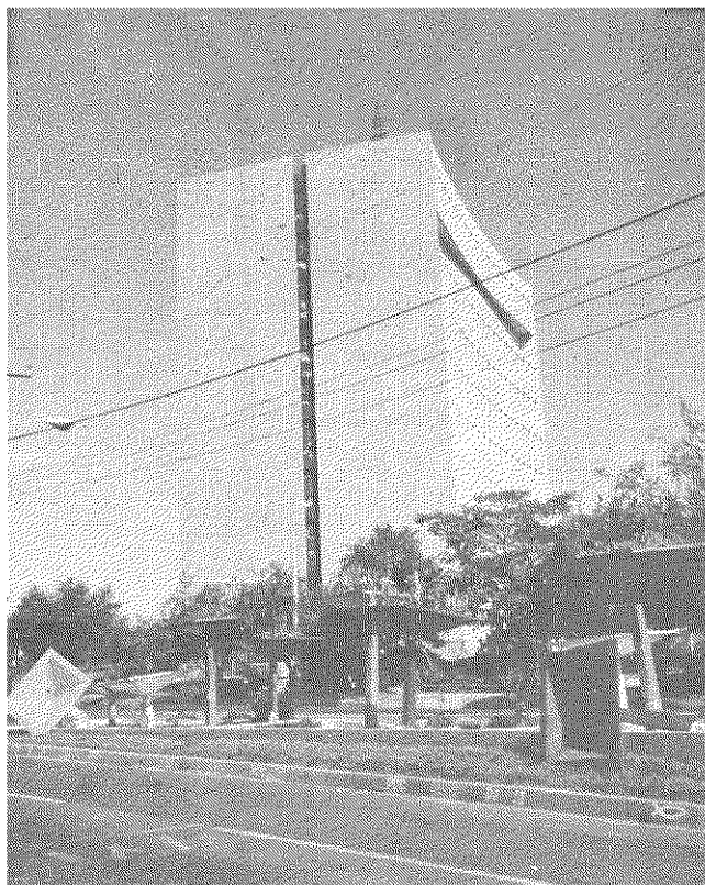
FOTO N° 21: Torre del Hospital Bloom. Los muros laterales son de concreto armado.
