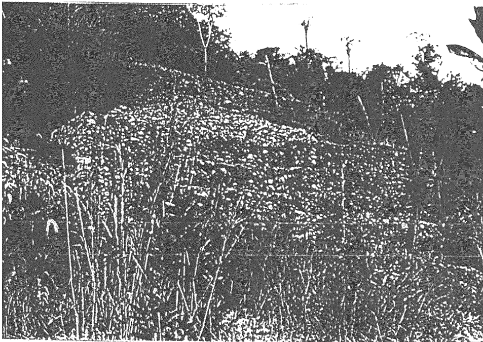
14. Vuelta del Queque Sta 2+800 a 2+900 Muro de gaviones unos 20 m bajo la banca.
