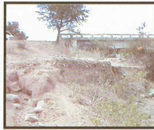
Río Peladero. Se observa la socavación del río amenazando con llegar al puente.
