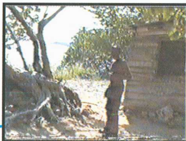
Casa en Cativar próxima al litoral, que ha sido afectada por las olas del mar.
