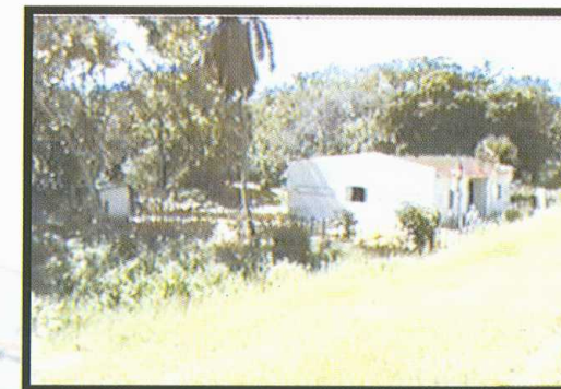
Escuela en Las Bijas, muy cerca del litoral, sometida a una alta corrosión y con peligro en caso de fuerte oleaje de penetración del mar.
