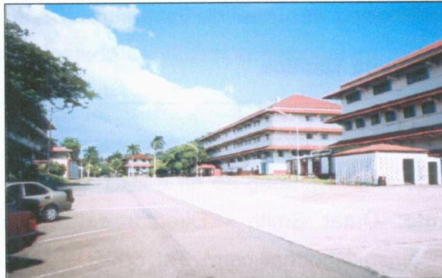
Instalaciones de SINAPROC
