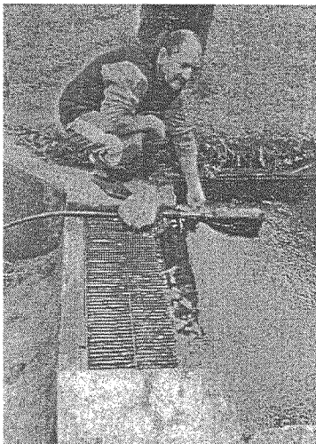
Foto No. 6 Bocatoma quebrada Santo Domingo
