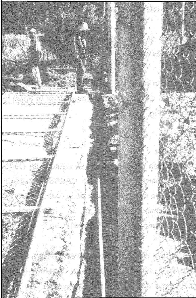
**Foto 23.** Portón de una industria en Las Manosas en la que se determinó un registro total de 27 cm. de desplazamiento cosísmico
