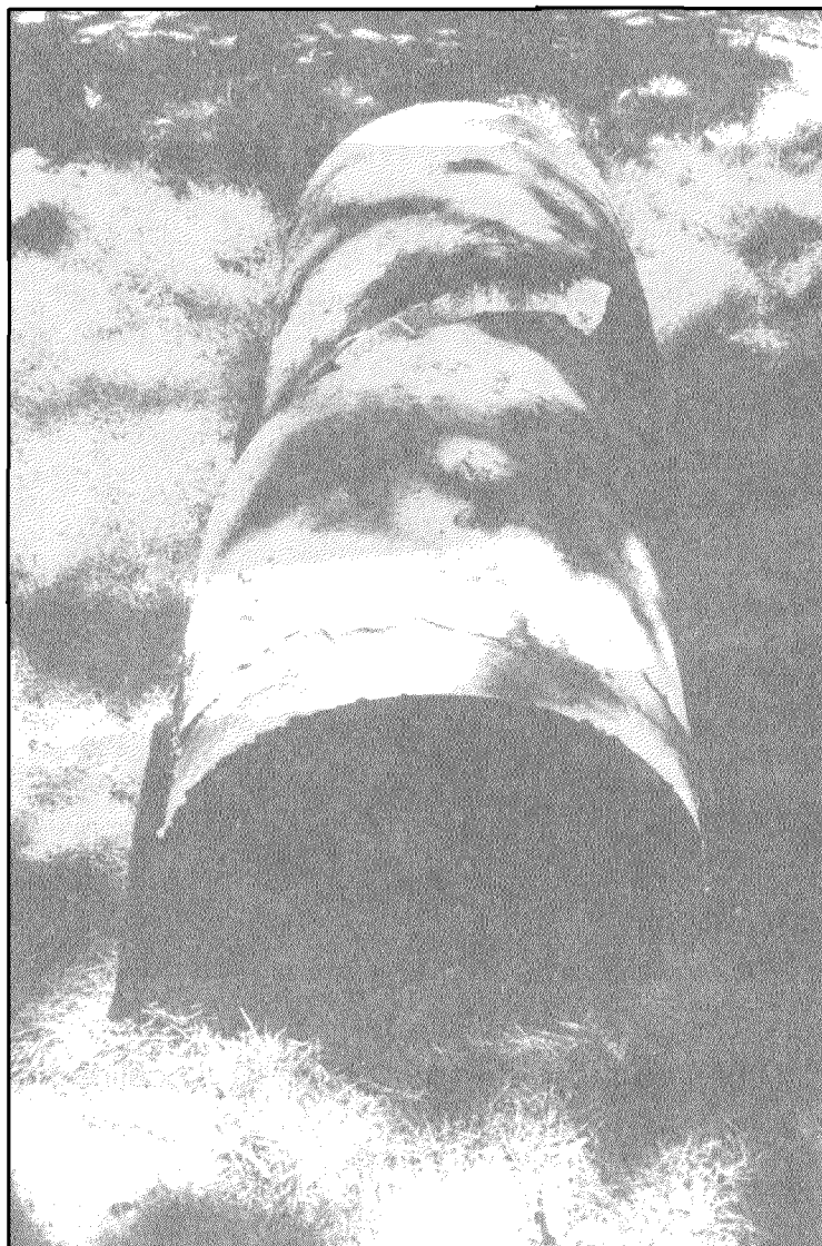
Foto 28. Tubería de agua traccionada. Localidad de Carrizal de la Cruz
