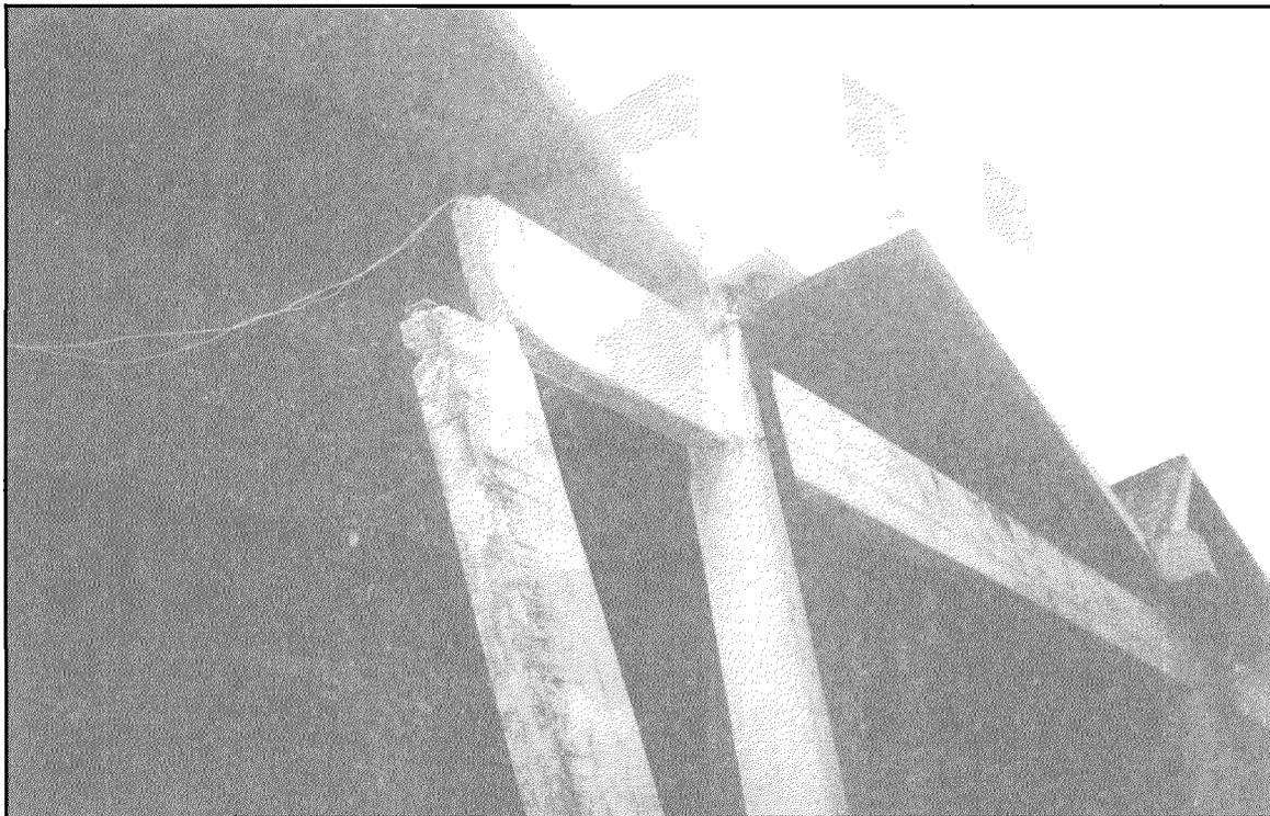
**Foto 47.** Liceo Pedro Arnal. Falla parcial de la conexión viga de techo columna-viga. Cumaná.
