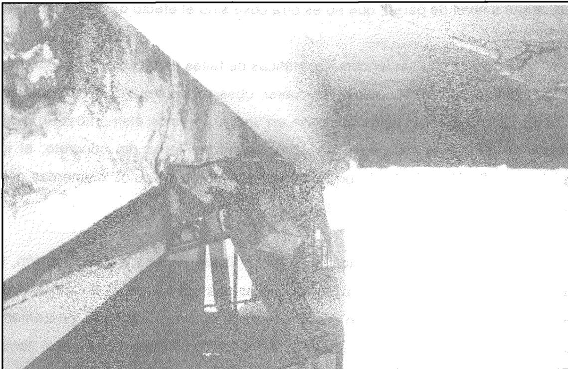
**Foto 67.** Colapso de la losa y falla de las juntas en la Escuela Valentín Valiente, Cariaco
