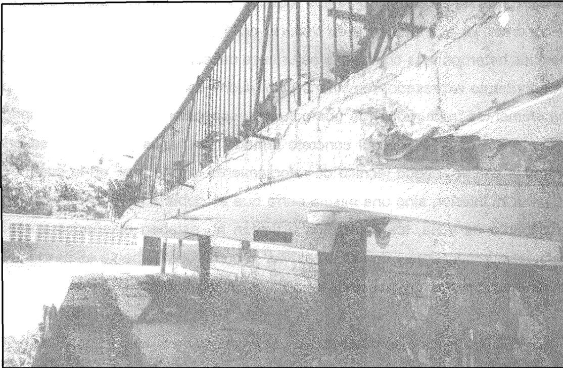
**Foto 66.** Deformaciones pronunciadas en la losa a causa de la onda sísmica. Escuela Valentín Valiente, Cariaco.
