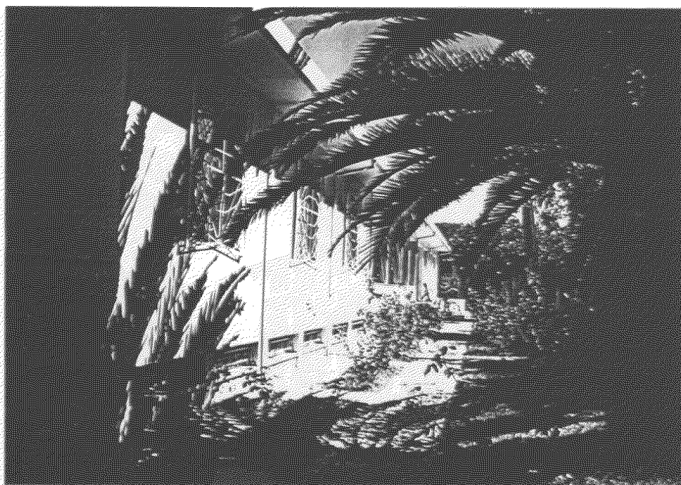
Foto 6. Vista de la fachada longitudinal del Hospital de Bertol
