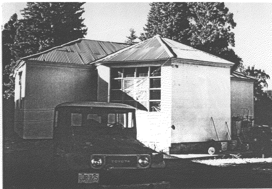
Foto 19. Vista del Auditorium del Hospital Carmen López
