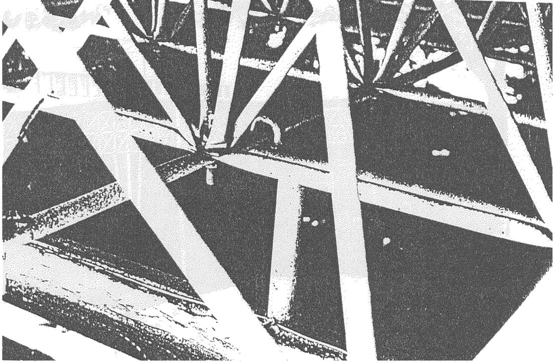
**FOTO 7.3 DETALLE DEL SISTEMA DE APOYO DE LA CUBIERTA DE LA ENTRADA DE EMERGENCIA**
