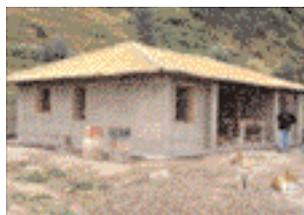
Mampostería de bloques de terrocemento, con mochetas en extremos. Insuficiente resistencia a sismos.
