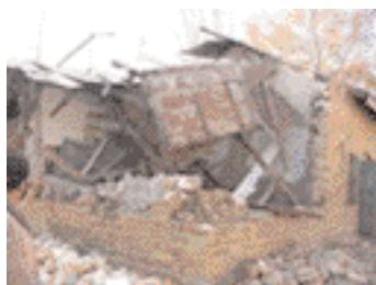
Hay que destacar que las estructuras de mampostería de ladrillo, adobe, terrocemento, bloques de concreto, etc., sin refuerzo interno y sin elementos enmarcantes resistentes a tensión, son altamente vulnerables al sismo, por ello hay que reforzarlas o en lo posible reemplazarlas.
