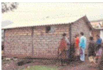
Estructura metálica enmarcante de las paredes de adobe. Cubierta ligera.
