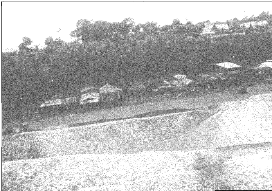
Foto 10: Ladrilleros detalle de construcciones sobre la playa
