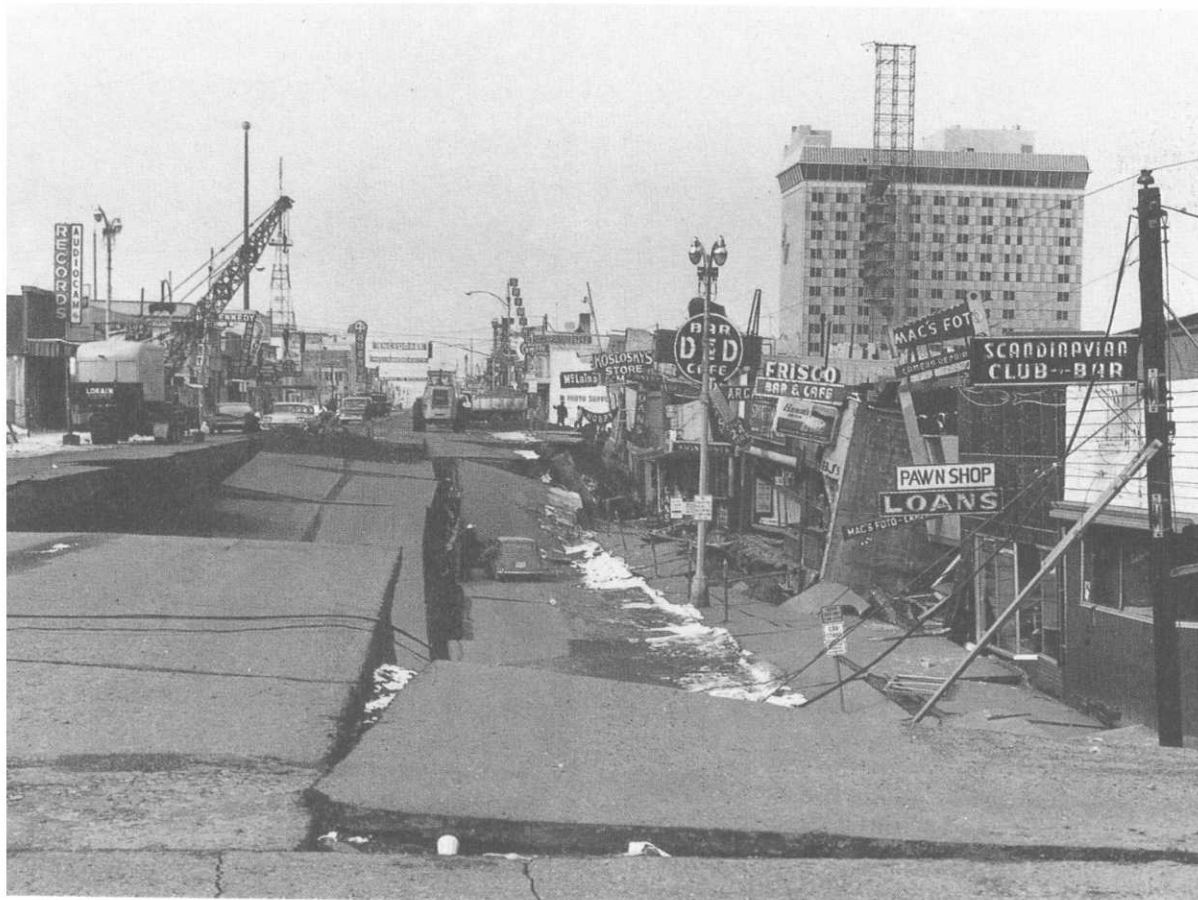
Durante el terremoto de Alaska, en marzo de 1964 (8.4-8.6 grados en la escala Richter), se produjo un corrimiento de tierra en el distrito de la 4ª Avenida de la ciudad de Anchorage. Las calles se encorvaron y se derrumbaron violentamente, y los edificios quedaron enterrados unos 4 metros. Fuente: US Bureau of Land Management. Nueva edición de "Confronting Natural Disasters. An International Decade for Natural Hazard Reduction", Academia Nacional de la Prensa, Washington, D.C. 1987.
