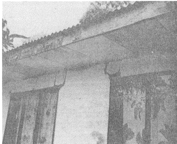
Figura N° 8 Pared con bloques sobre las ventanas.
