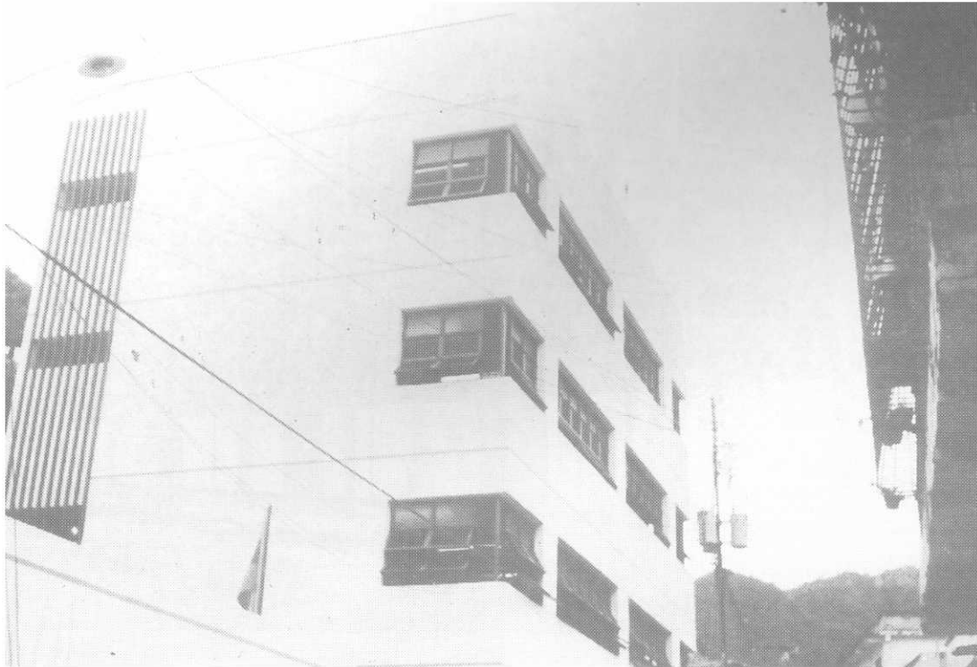
Sistema Módulo de Barrios, E.B. Los Naranjos, Caracas, Distrito Federal
