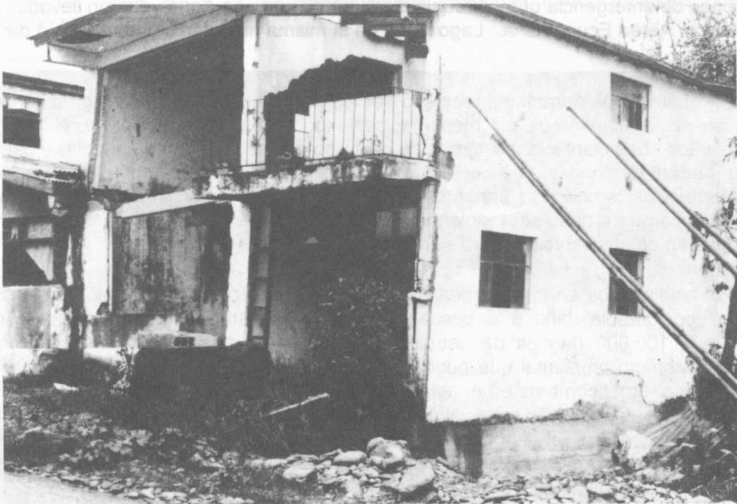
**FIGURA 7.2** Domicilio de bloque de concreto dañado en Baeza. Provincia del Napo.
