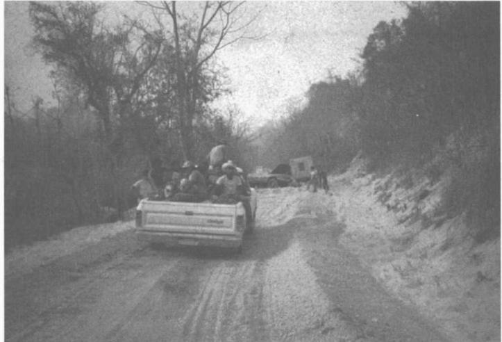
**Fig. 25.** La ceniza depositada sobre las carreteras puede inhabilitarlas parcial o totalmente. La foto muestra las dificultades de evacuación en una carretera parcialmente cubierta de ceniza durante la erupción del volcán El Chichón, en 1982. Foto de S. De la Cruz.
