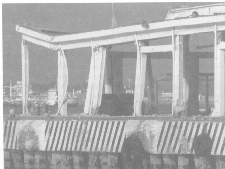
Figura 6.1 Estructura sobre el muelle fiscal
