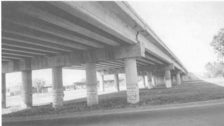
Figura 6.5 Vista general del puente "Manzanillo"
