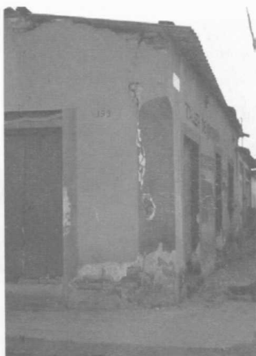
Figura 7.73 Agrietamiento de vertical en muros de esquina
