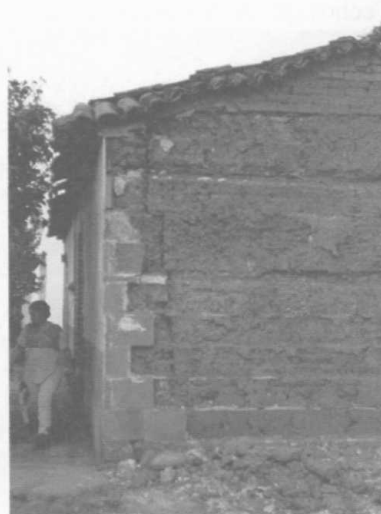
Figura 7.73 Agrietamiento de vertical en muros de esquina
