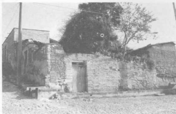
Figura 7.71 Muros de adobe, piezas de arcilla recocida, piedras o una combinación de estas
