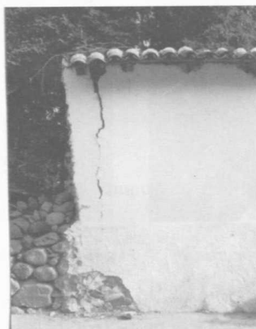
Figura 7.80 Agrietamiento vertical en muros de esquina y su consecuente separación de muros en vivienda con muros de adobe y piedra
