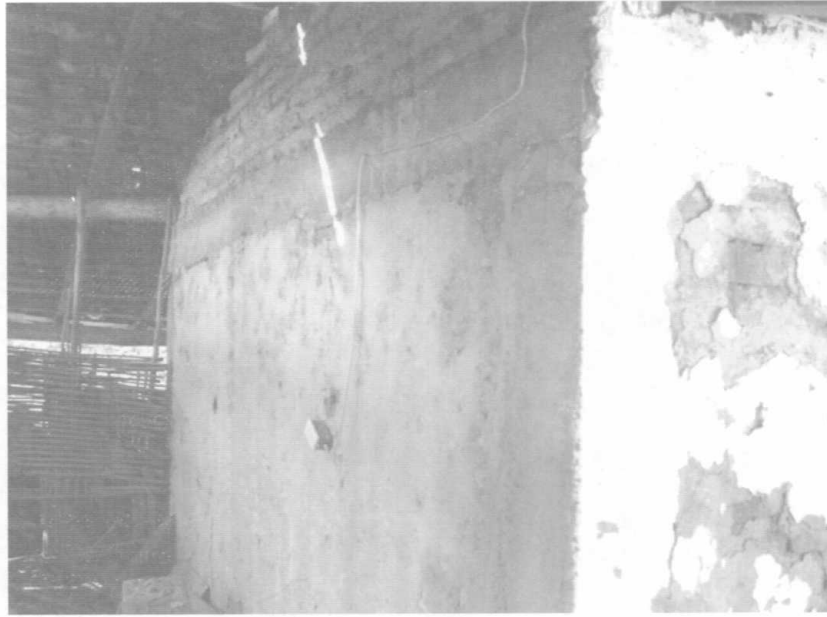
Figura 7.112 Muro de adobe rehabilitado con dalas y castillo
