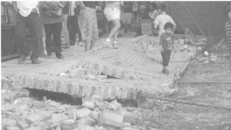
**Figura 7.130** Caída de barda de mampostería confinada con defectos
