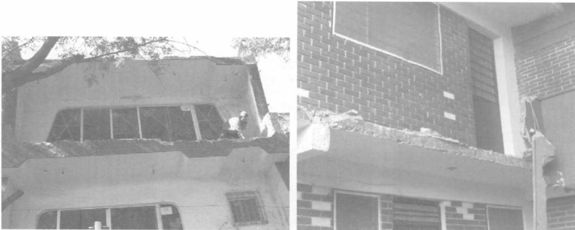
**Figura 7.133** Pretiles como barandal en balcones y pasillos. En la foto de la derecha el pretil tenía cadena horizontal, pero el castillo estaba mal anclado en su base
