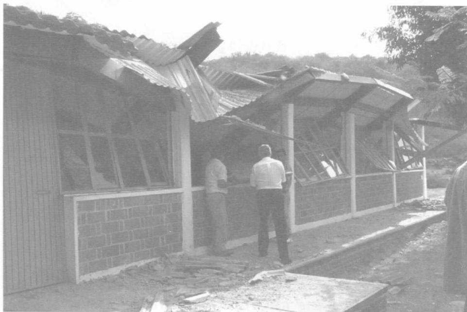
Figura 8.20 Falla del sistema de techo de un edificio escolar
