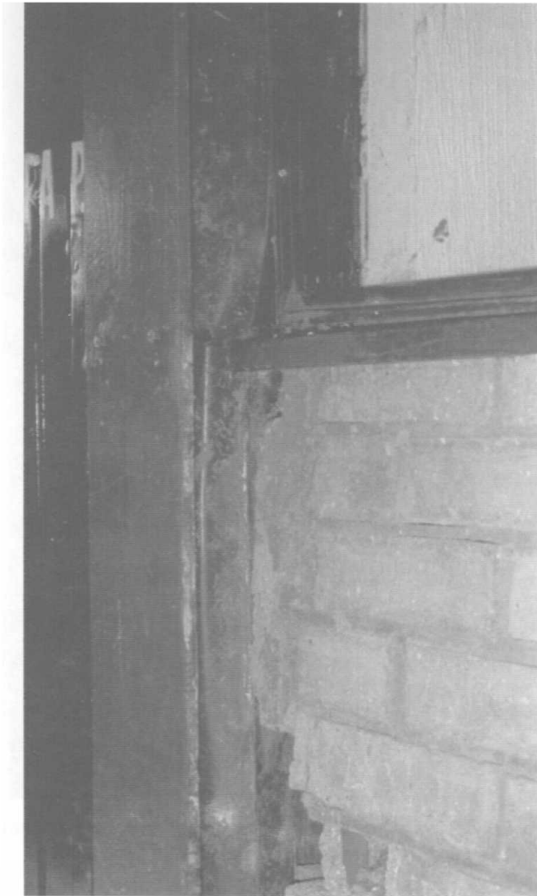
Figura 8.16 Deficiente separación de los muros de relleno en una escuela secundaria en el poblado de El Chante, municipio de Autlán de Navarro
