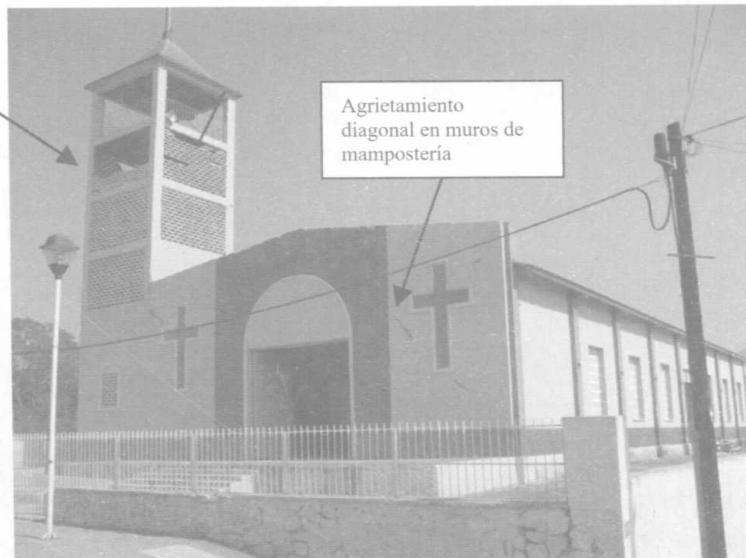
Figura 10.9 Vista exterior del daño de la iglesia de Ixtlahuacán
