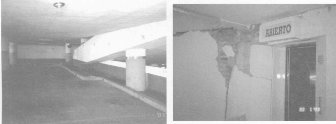
Figura 12.2 Vista interna del edificio y daño en el muro junto al elevador Sur
