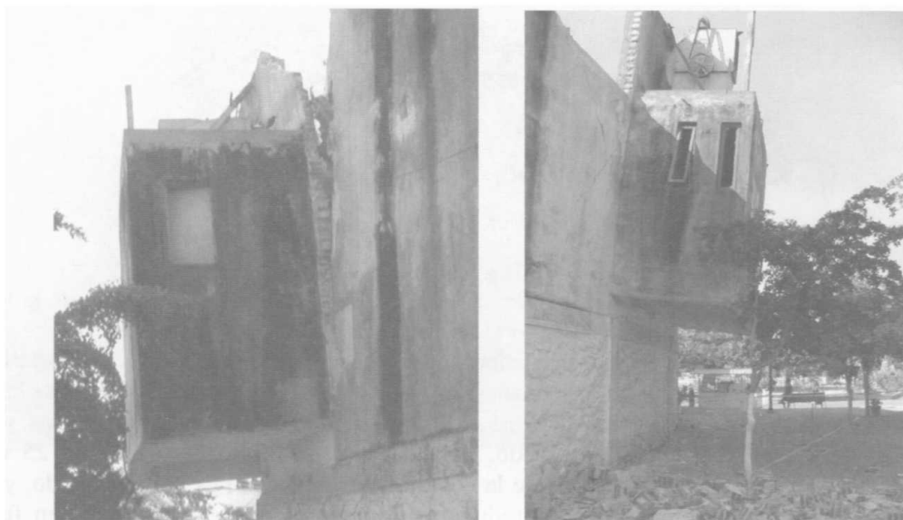
Figura 12.5 Daño e inclinación de la cabina de proyección
