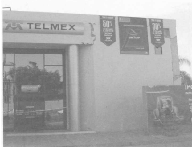
Figura 12.3 Fachada frontal del edificio
