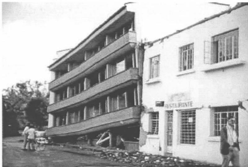
**Foto 6.1:** A la izquierda se aprecia un edificio nuevo en Colombia, construido por profesionales, que ha colapsado y a la derecha una casa informal sin mayores daños. En este caso, el edificio nuevo demostró ser más vulnerable que el informal.
