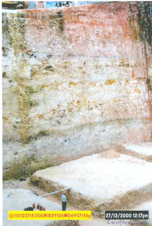
EXCAVACION DE 24 METROS DE PROFUNDIDAD PARA LA CONSTRUCCION DE UNA TORRE EN STO. DOM.
