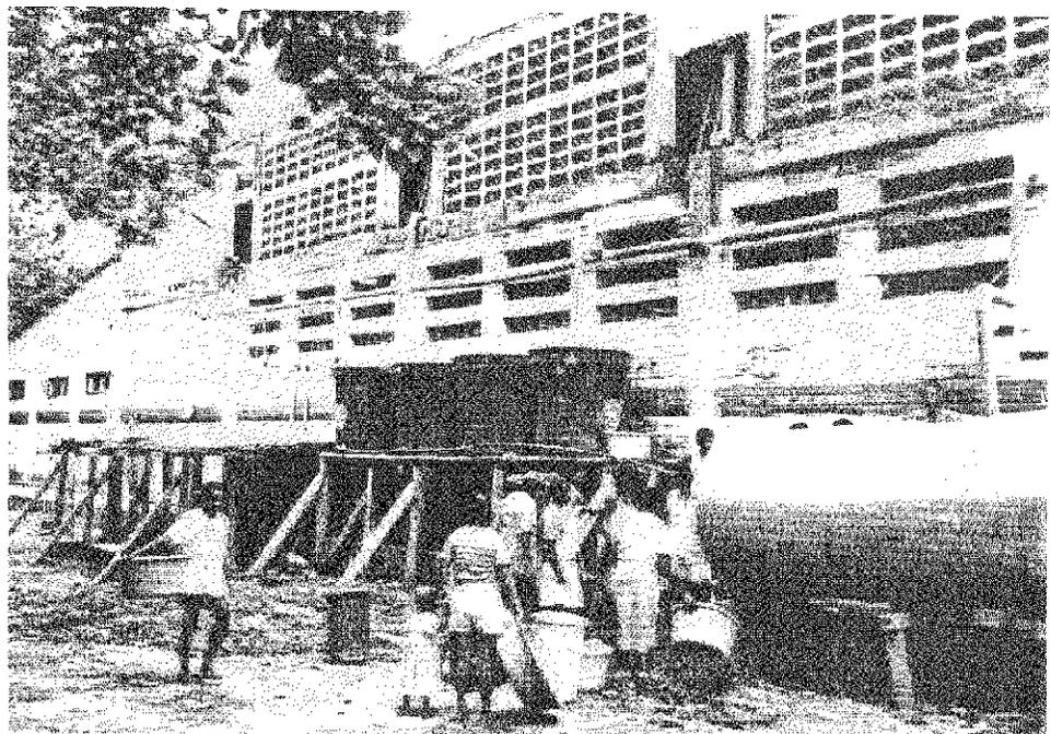
Sistema de captación de aguas lluvias y almacenamiento del agua para la correspondiente distribución para uso domiciliario
